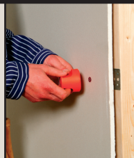
Sök upp den dolda insatsen med HOLE IN ONE sökare 8:21 eller Supersökare 2000 och märk ut centrum.
