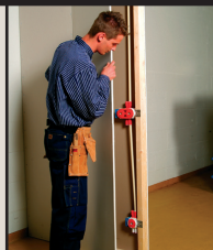
Montera gipsplattan / panelen.
